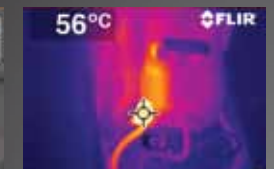
Das sieht eine Wärmebildkamera.
