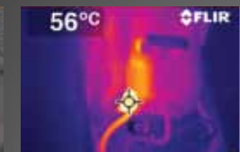
Das sieht eine Wärmebildkamera.
