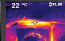
Das sieht eine Wärmebildkamera.
