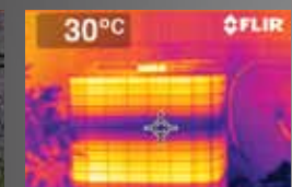
Das sieht eine Wärmebildkamera.
